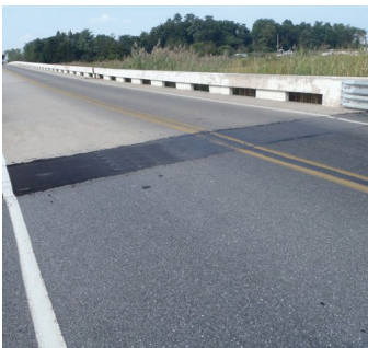
Acercamiento de cubierta del puente
