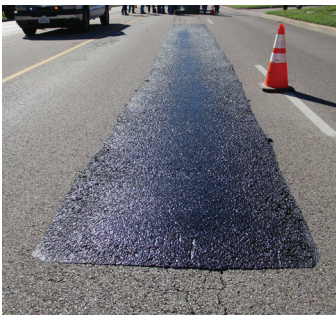
Reparación de superficies
